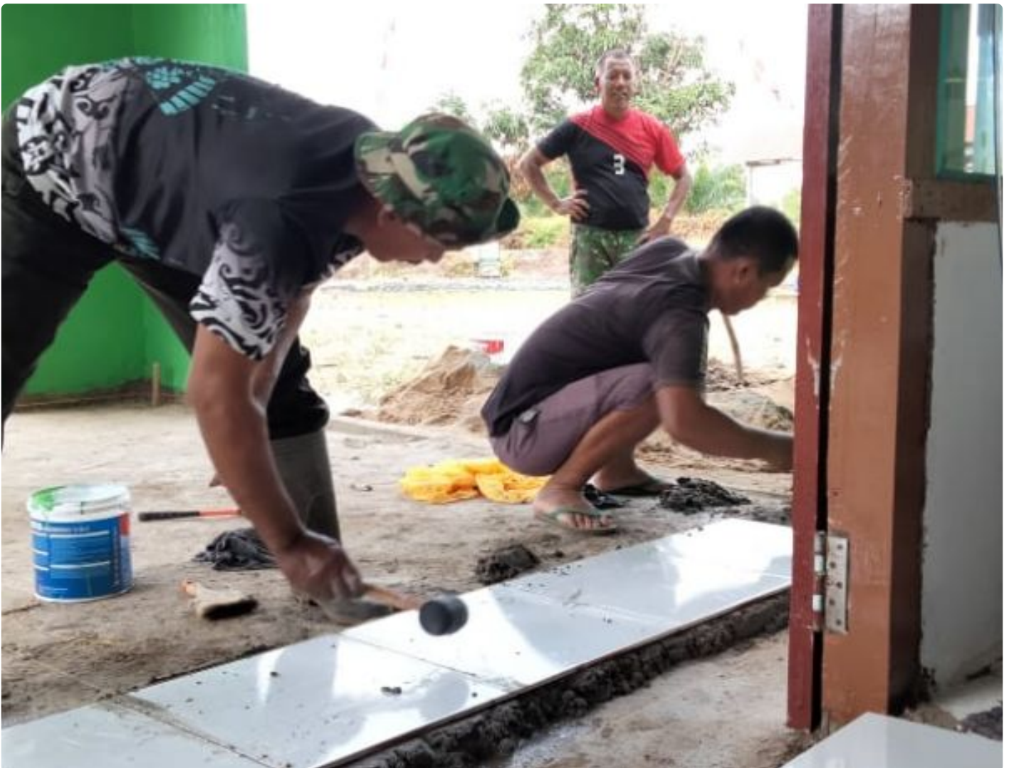
Satgas TMMMD Ke-113 Kodim 1005/Barito Kuala Pasang Keramik Teras Masjid
